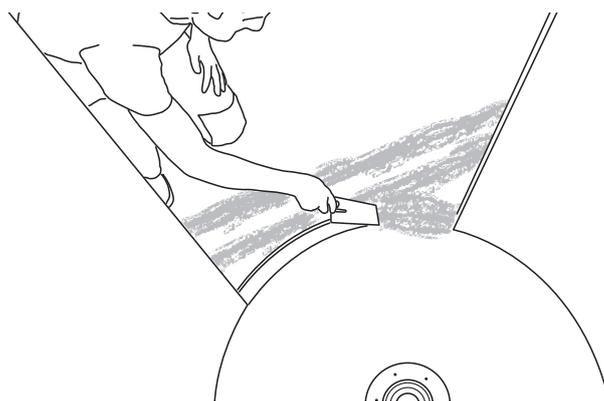
**12)** Nella zona d'ingresso la scanalatura viene riempita di collante per piastrelle e, una volta indurito, sigillata con il set sigillante bi-componente (o equivalente) JACKOBOARD®.
