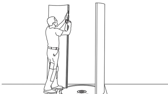
**4)** I singoli elementi della parete vengono incollati con l'adesivo e il sigillante BOARD-FIX®. L'adesivo assicura il collegamento a forza degli elementi e allo stesso tempo la tenuta del giunto di testa. L'adesivo deve quindi essere applicato in maniera spessa, in linea e senza spazi vuoti sul lato lungo. È sufficiente applicare l'adesivo su una superficie adesiva.
