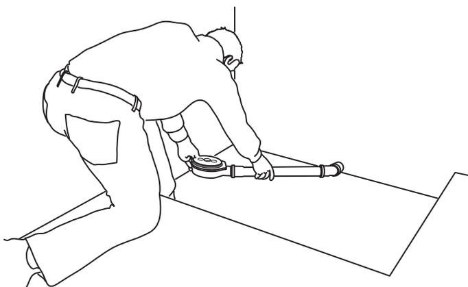
**4)** Lo scarico a pavimento viene inserito nel tubo di scarico DN 50 già presente in loco. Lo scarico a pavimento viene portato alla giusta altezza (vedi figura "Altezza di montaggio", pag. 6 e 7). Per pavimenti con isolamento anti-calpestio va previsto il montaggio di un isolamento adatto e di strisce isolanti ai bordi.
